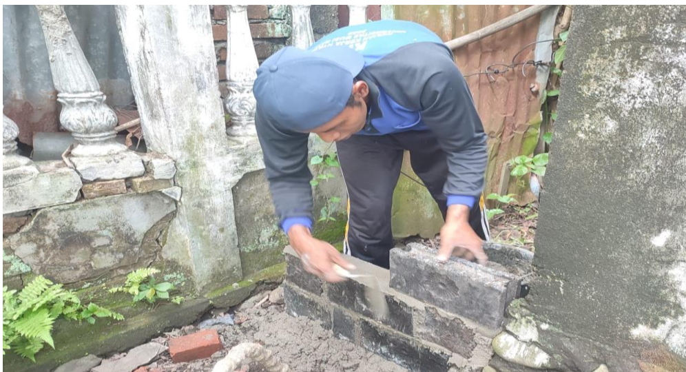
Gambar 7. Penggunaan batako sebagai pasangan didnding
