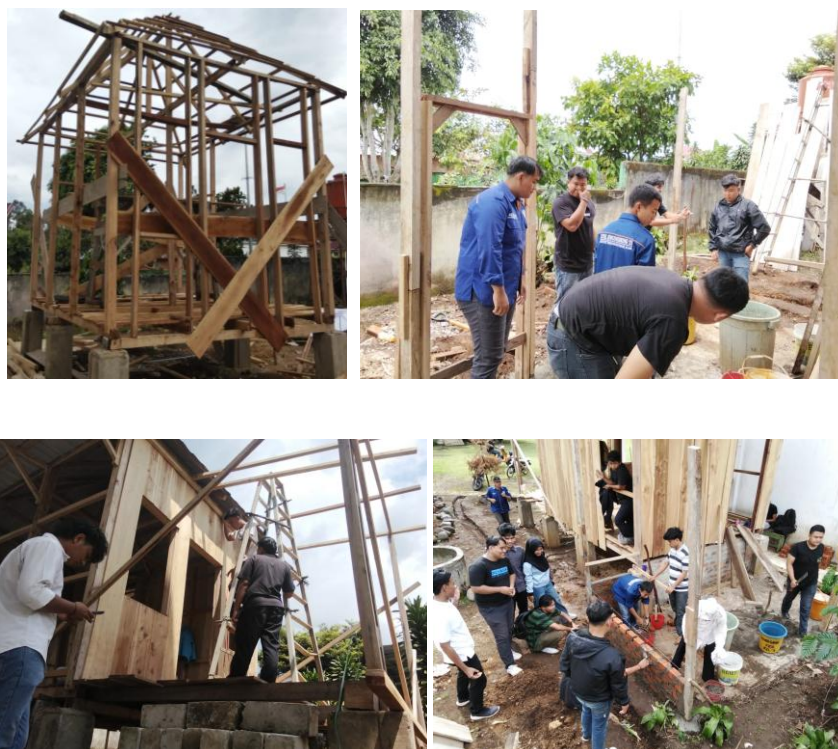
Gambar 4. Proses Pembangunan Rumah Singgah
